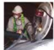
Limpieza de Depósitos
