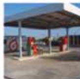
Instalación de Estaciones de Servicio
