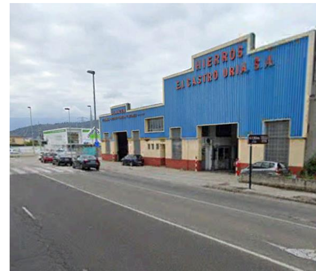
Figura 35: Naves Industriales avda. de Asturias
