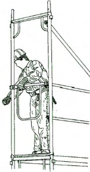
Figura 17. Colocación de barandillas esquinales.
