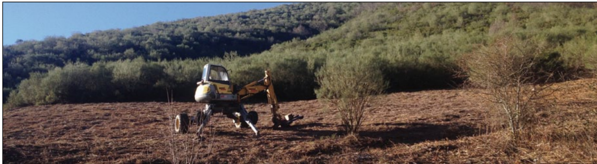
Retroaraña realizando trabajos de desbroce en Degaña (Asturias). Foto: Marcos Casares Álvarez
