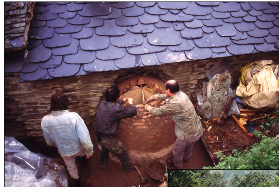
Reconstrucción de Horno tradicional
