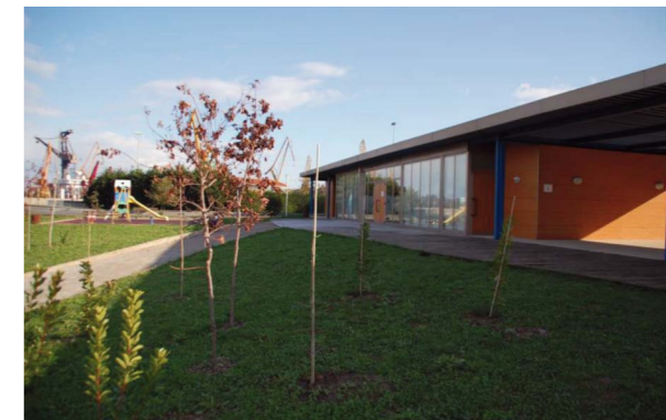
La restauración de la Marisma Negra incluyó la construcción de este edificio para su uso como centro de información y educación ambiental y que gestiona SEO/BirdLife
