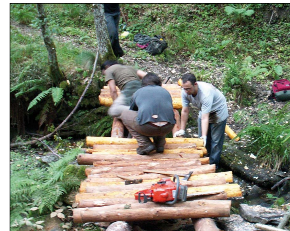
Construcción de puente
