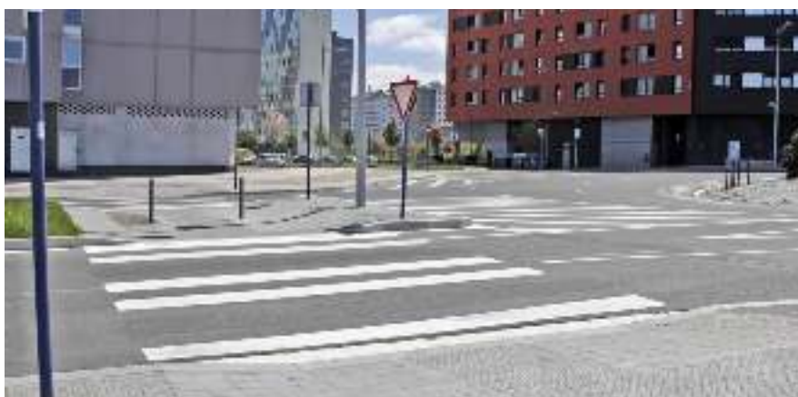
Vitoria-Gasteiz (Álava). Paso peatonal adaptado a bicis. La eliminación de una de las bandas de pintura disminuye el riesgo de resbalar en casos de lluvia.
