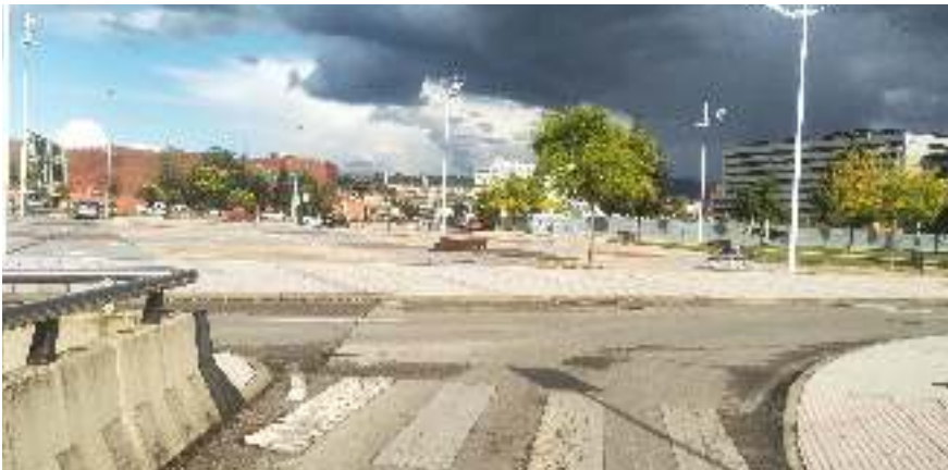
Avenida de la Constitución. La potencial alternativa al paso subterráneo está interrumpida por el bulevar de Juan Carlos I.
