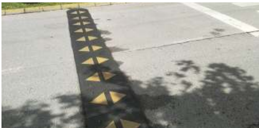
Avenida del Castillo. Reductor de velocidad de caucho.
