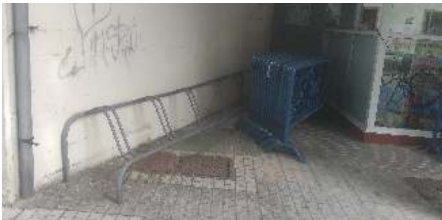
Centro Cívico Flores del Sil. Aparcabicis de modelo inadecuado y en parte inutilizable por falta de espacio.
