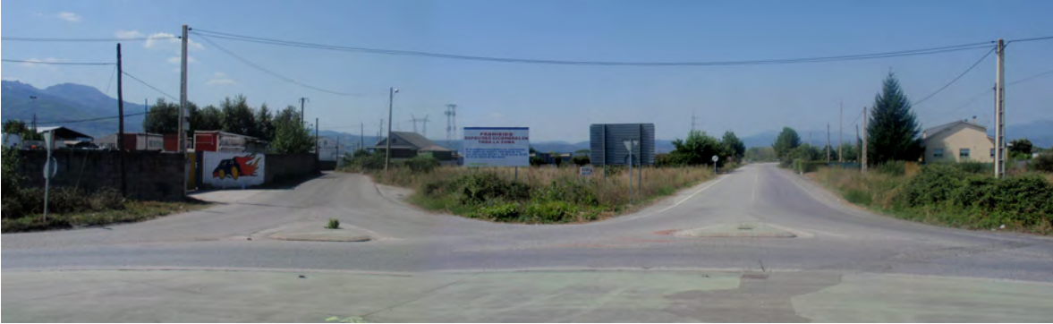
Imagen desde la glorieta de la Av.Milán. A la izda. Vial acceso al sector y a la dcha. la prolongación de la Avenida hacia la N-536
