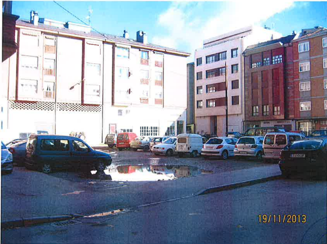
Aspecto actual desde la Calle Monasterio de Montes, con charcos y desniveles.
