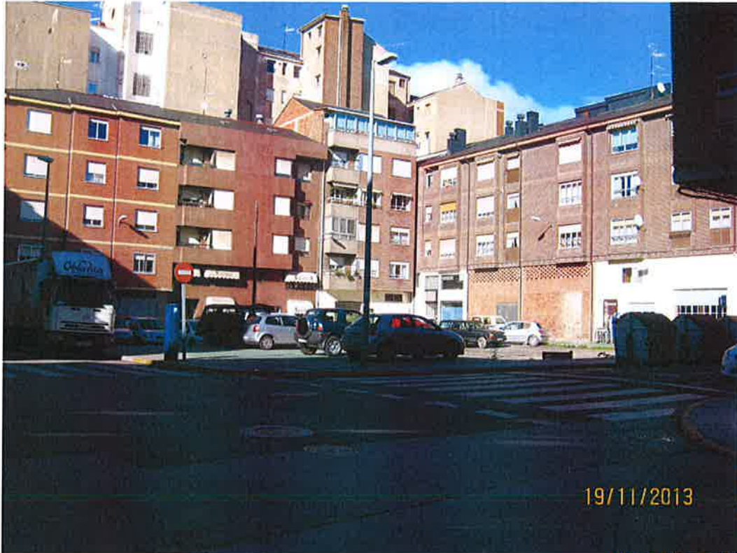
Estado actual de la Plaza Sánchez Albornoz.
