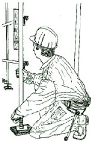
Figura 11. Comprobación de la nivelación vertical
