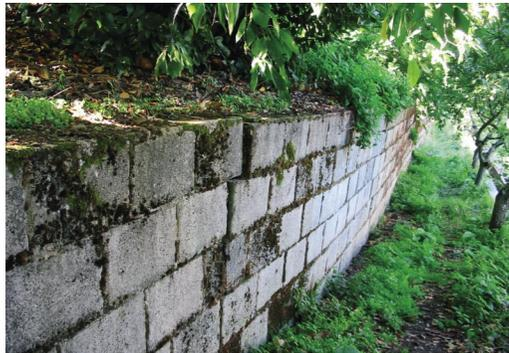
En los informes técnicos realizados siempre se ha insistido en la necesidad de proceder a consolidar el muro de contención del talud sobre el que se levanta el ciprés, ya que presenta debilidades estructurales con riesgo de caída.
