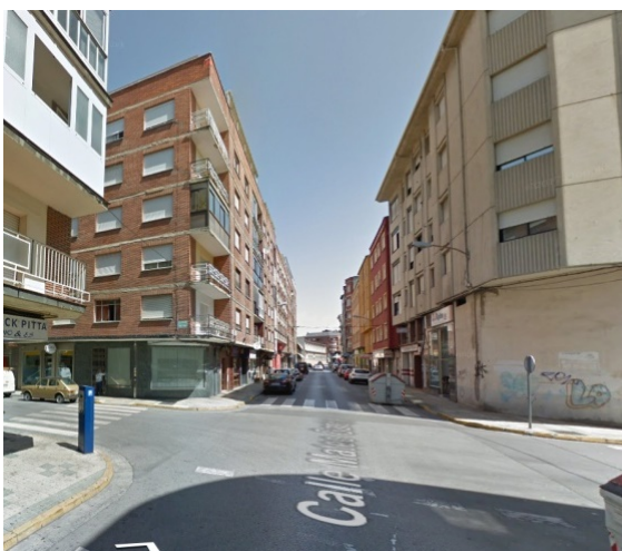
Imagen del viario central antes de la intervención
