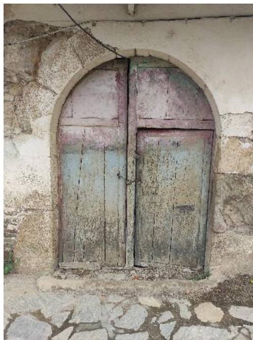
Puertas de acceso adintelada y de medio punto de construcciones del siglo XVIII de Salas de los Barrios.
