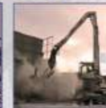
Desguaces y demoliciones industriales
